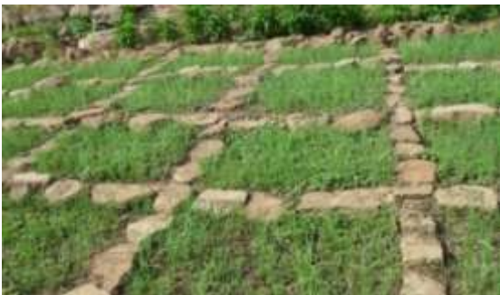
Mise en place diguette (wolo- wolo)
