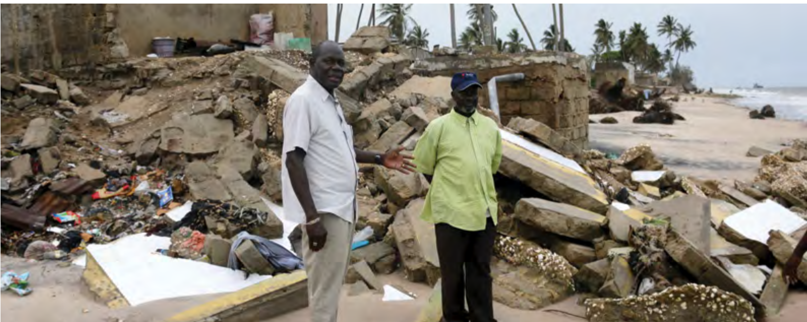
• Maisons détruites par le raz-de-marée à Palmarin, Sénégal. Septembre 2015.
